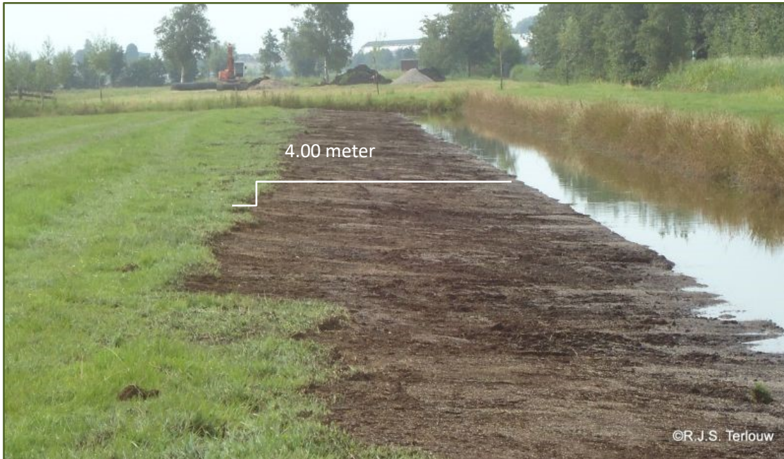
Figuur 11. Flauw talud oever aan zuidzijde
