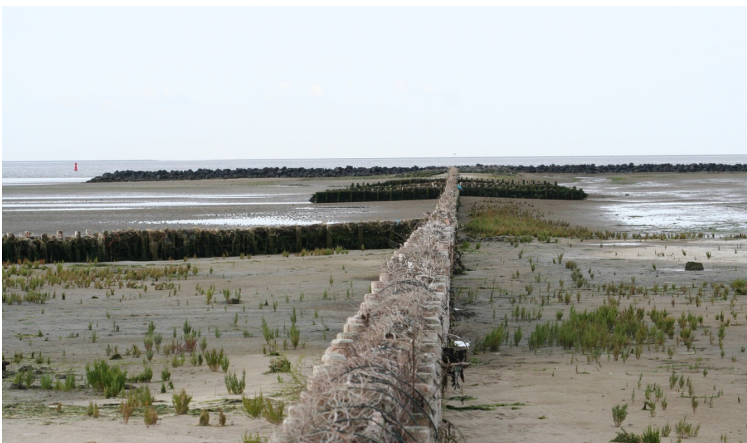
Rijshoutendammen creëren rustige omstandigheden, zodat sedimentatie plaats vindt.
