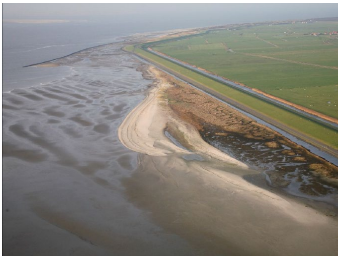
Luchtfoto Feugelpôle (rechts) met deel van Vrijheidsplaat (links) en stortstenen dam en Westerkwelder op achtergrond.
