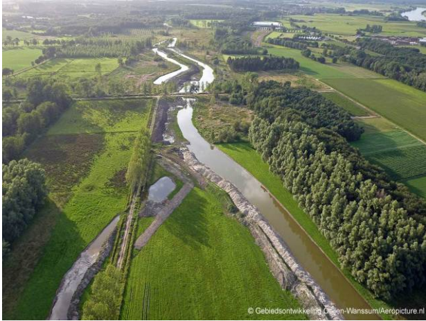
zomer 2012, tijdens aanleg
